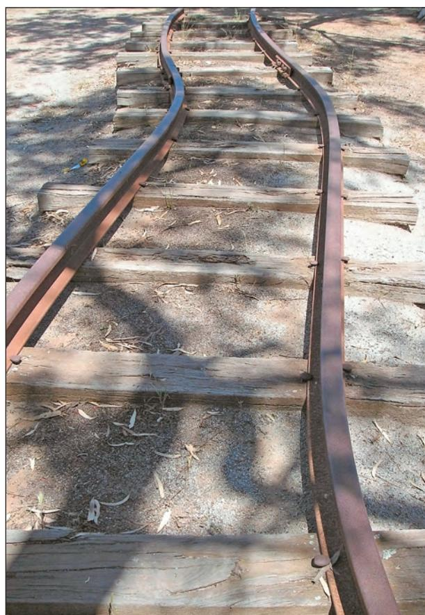
Рис.4. Искривление рельсов железной дороги в Мекеринге.
