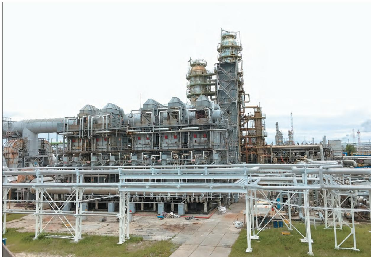
Блок риформинга (показана секция комбинированной установки производства моторных топлив Сургутского завода стабилизации газоконденсата(РП)). Блок каталитического риформинга бензиновой фракции вырабатывает базовый высокооктановый компонент бензина (около 1 млн т в год) с пониженным содержанием вредных ароматических углеводородов на цеолитсодержащих катализаторах серии ГПС, разработанных в ООО «НПФ «ОЛКАТ»».
